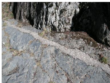
Canalización de agua sellada con cemento
